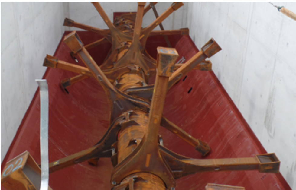
Mit Regenwasser betriebener Fermenter der RMB im Bau
